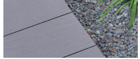
nach Reinigung mit Wasser
